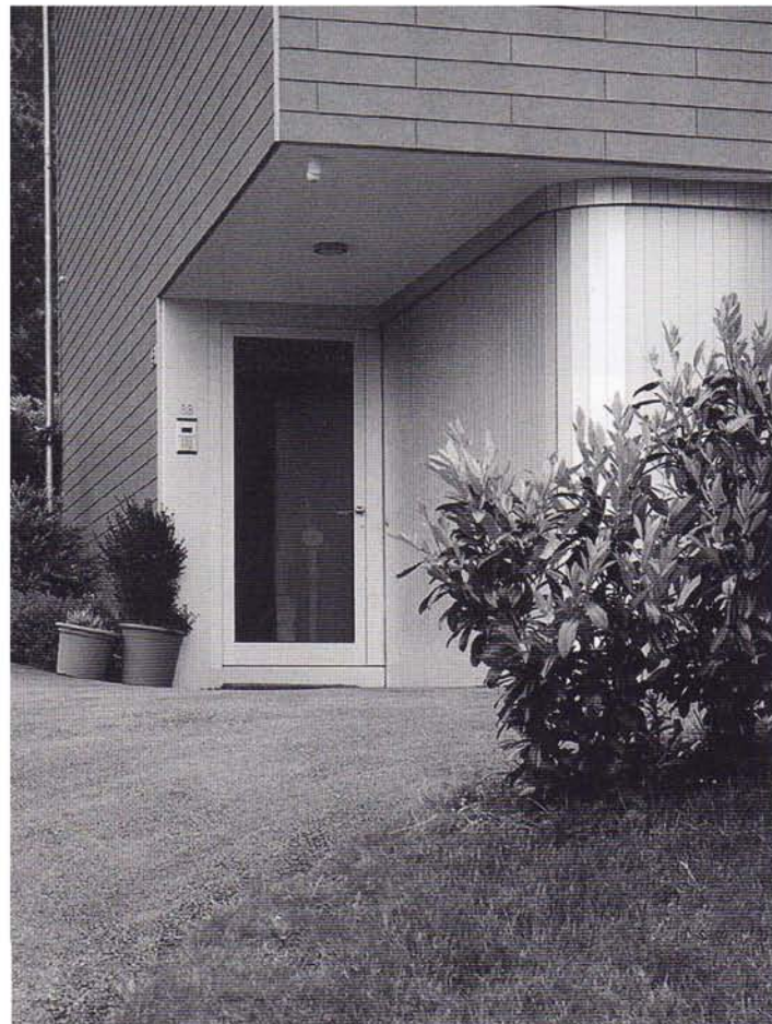
Hauseingang mit verschlossenem Stellplatz.
